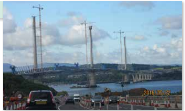
フォース湾の新道路橋 (2016年) Queensferry Crossing
