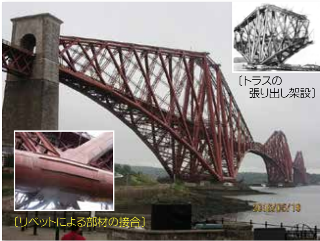
図-2 フォース鉄道橋 (1890年) Forth Rail Bridge
