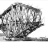
[トラスの張り出し架設]
