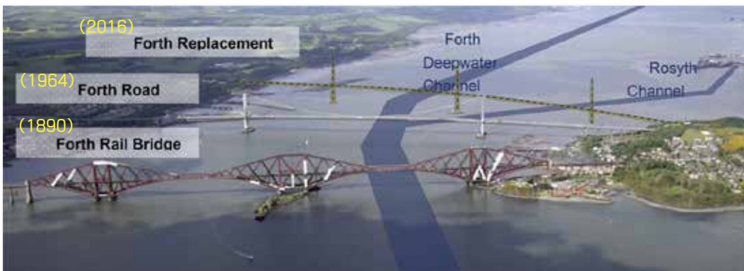
図-1 フォース湾の3橋 Forth Bridges
