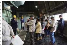
大沼地熱発電所
