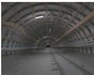
図4 支保が整備された坑道
