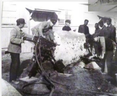
削岩実習の様子。学生たちはドリルで火薬の埋込み穴を開けている
