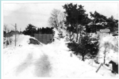
建設前の様子
