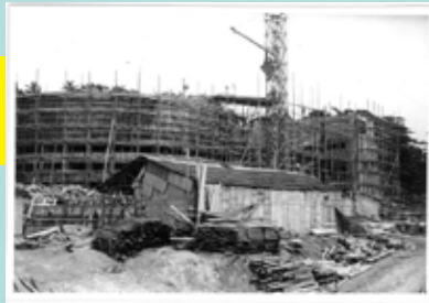
建設途中の様子
