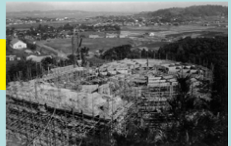
建設途中の様子
