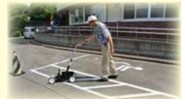
博物館駐車場の白線引き作業
