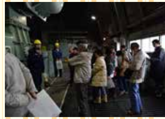
タービン・発電機の見学 送られた蒸気は、タービン・発電機を駆動して発電します
